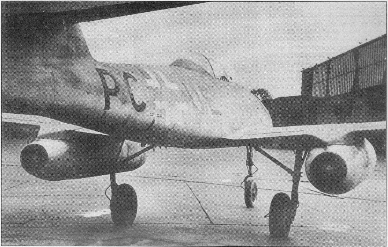
Me 262 V5 (PC+UE), W.Nr. 262000005 с неубирающимся трехстоечным шасси.
